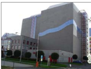
Energetický audit budovy mestského archívu hl.mesta Praha – rok 2004
